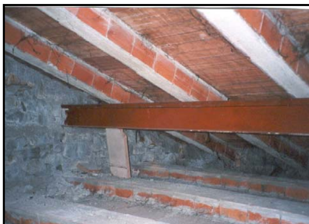
Copertura fragile e deformabile con travetti tipo SAP e tavelloni (120 cm) disposti in senso spingente.
