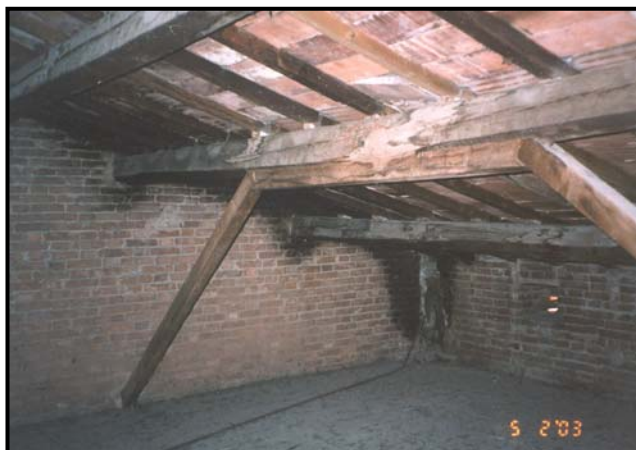
Copertura in legno con travi principali orizzontali.
