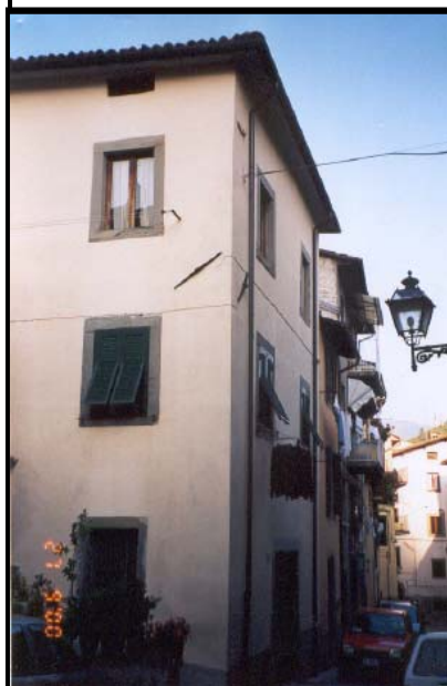
Catene disposte non a tutti i livelli.
