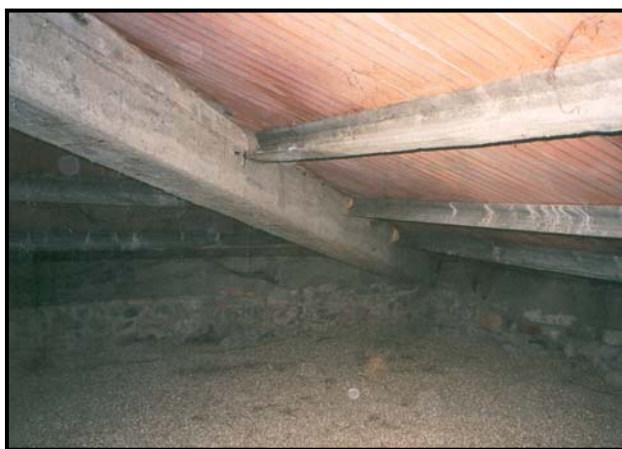
Copertura a padiglione con puntoni diagonali spingenti in cls.
