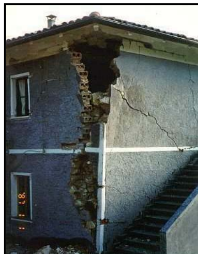
Danni provocati dalla spinta del puntone diagonale di una copertura a padiglione per effetto del sisma.
