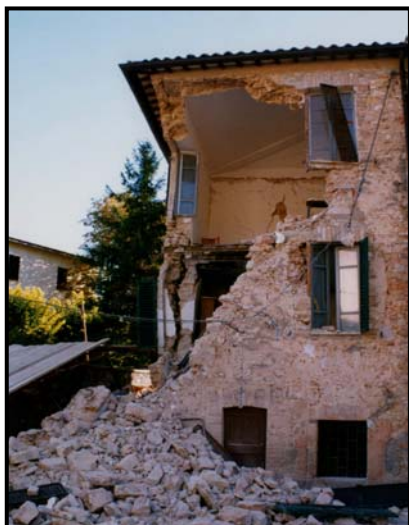
Danni provocati dalla spinta del puntone diagonale di una copertura a padiglione per effetto del sisma.
